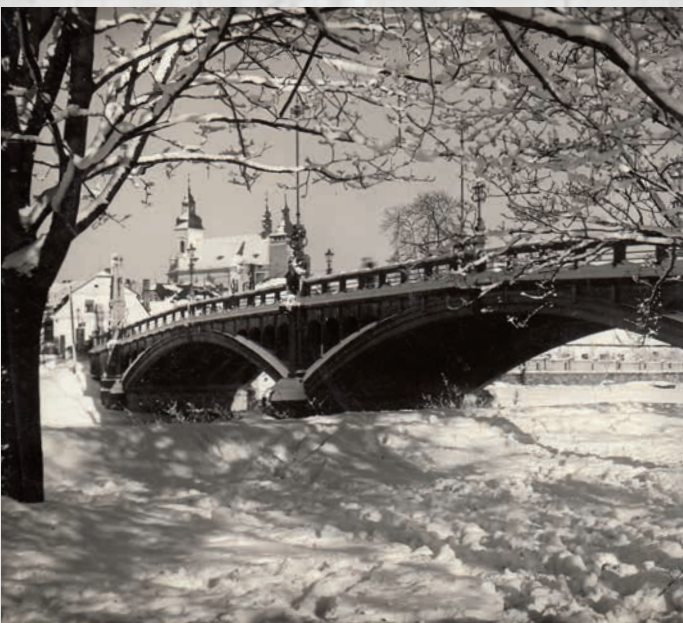
Obloukový most přes řeku Bečvu na Mostní ulici v Hranicích.
