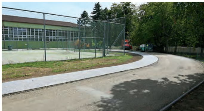
Letní horka práce na rekonstrukci hřiště rozhodně neulehčovala. Foto: Petr Bakovský
