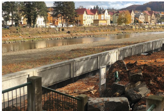
Hráze se zvyšují na obou březích Bečvy v délce zhruba 700 metrů. Foto: Barbora Kaštovská
