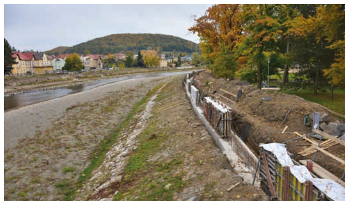
Mezi budovaná protipovodňová opatření patří i vyšší hráze nad mostem. Foto: Petr Bakovský
