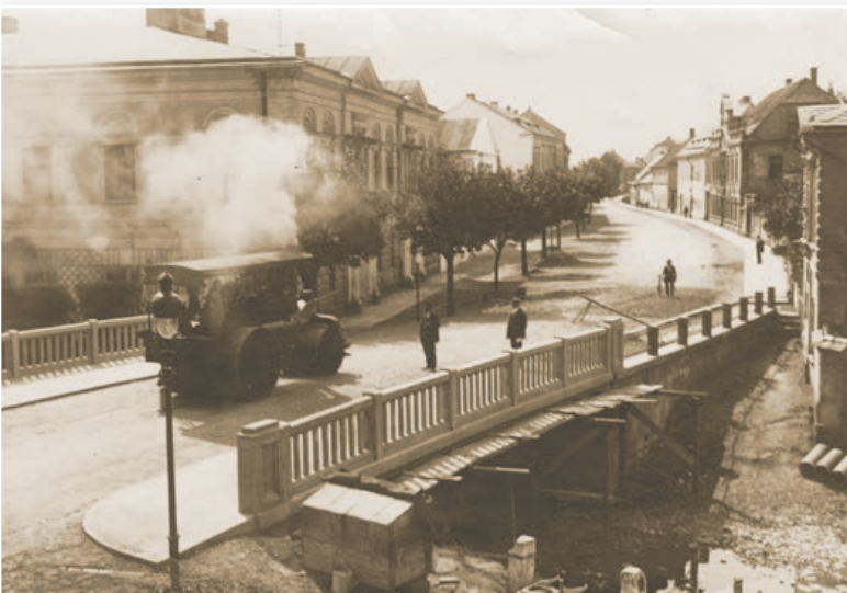
Fotografie z dvacátých let 20. století zachycuje zatěžkávací zkoušku na nově postaveném mostě přes Ludinu.
