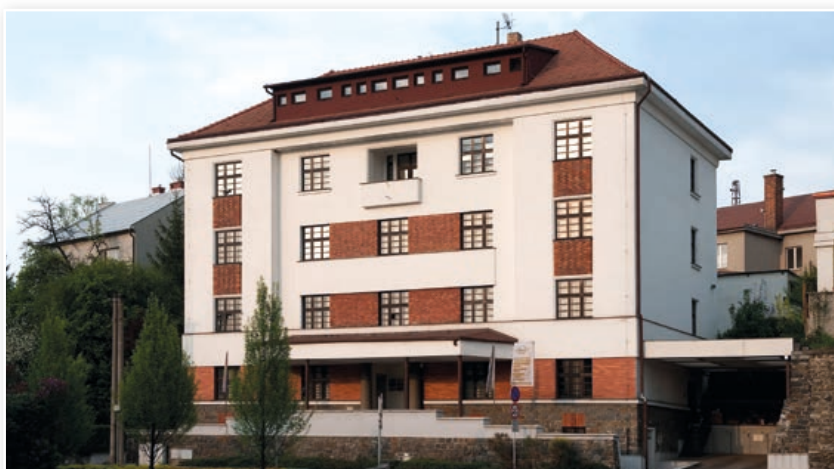
Činžovní dům pro vojenské gážisty v Galašově ulici. Dům od olomouckého architekta Josefa Macharáčka byl postavený v roce 1925 a je prvním z činžovních domů vybudovaných v období první republiky městem pro zaměstnance vojenských škol. Třípatrová budova stojí na vysokém soklu z neomítaného kamene. Jednoduše řešená fasáda s hladkou omítkou byla mezi okny kombinována s rezným zdívem. Foto: 7 x Tomáš Pospěch
